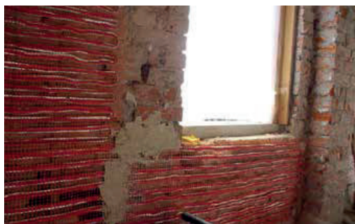
Aplicarea sistemului incalzit pe perete de caramida
