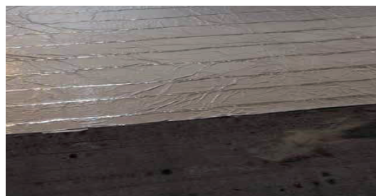
INSTALAREA FOLIEI DE DEGIVRARE
