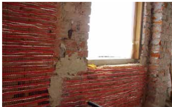
Aplicarea sistemului incalzitor pe perete de caramida
