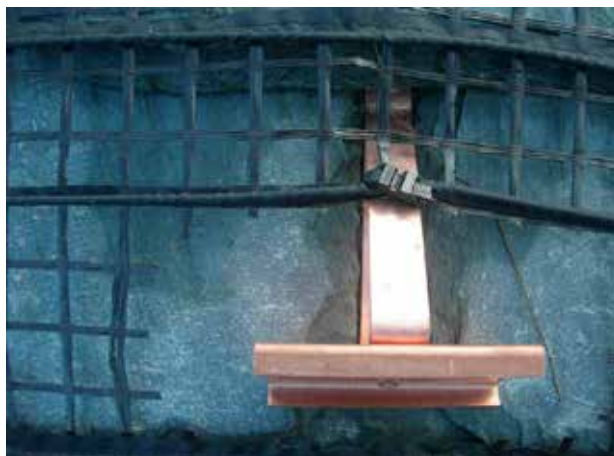
PRINDEREA DE BARIERA DE ZAPADA UTILIZAND UN COLIER
