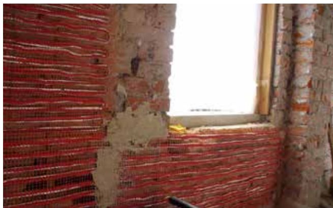
Aplicarea sistemului incalzitor pe perete de caramida
