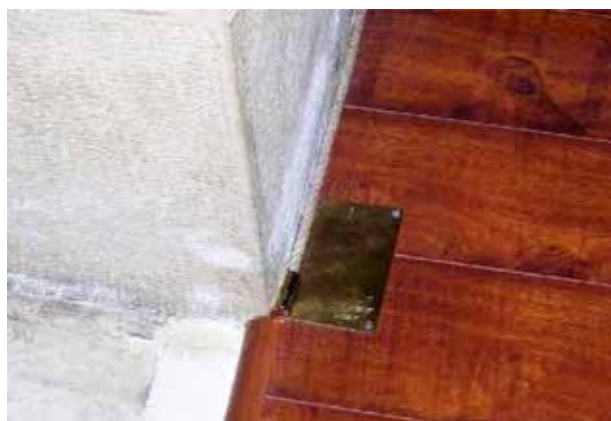
LOCATIA SI PROTECTIA CUTIEI DE DERIVATIE DIN ALAMA
