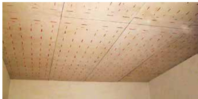
INSTALAREA PANOU RADIANT PE TAVAN
