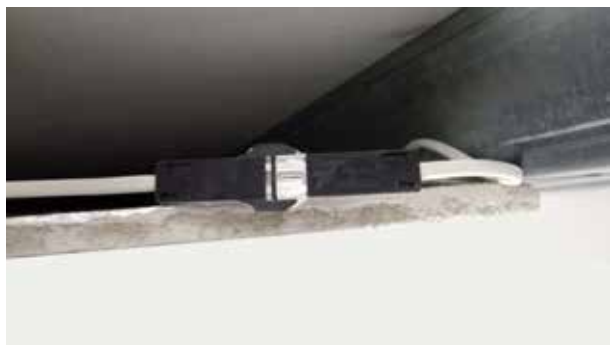
INTERCONECTAREA PANOURILOR CU AJUTORUL CONECTORILOR II DE 8A SI CLASA DE PROTECTIE IP 67
