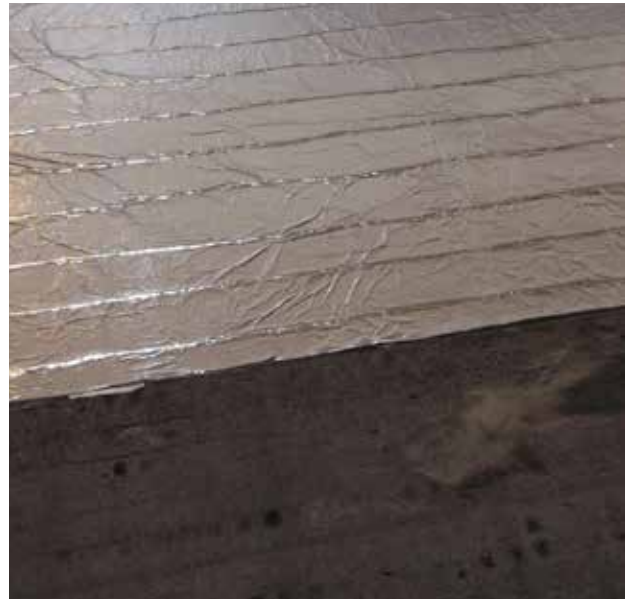
INSTALAREA FOLIEI DE DEGIVRARE
